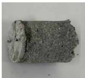
外壁吹付塗材
