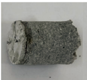
外壁吹付塗装
